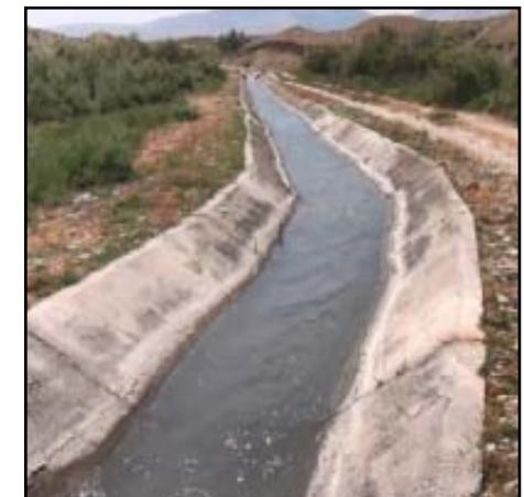
uzunluğunda beton üzüllü açıq suvarma kanalı və 2300 hektar ərazini əhatə edən 26 kilometr açıq, 121 kilometr isə qapalı drenaj şəbəkəsi çəkilib.
